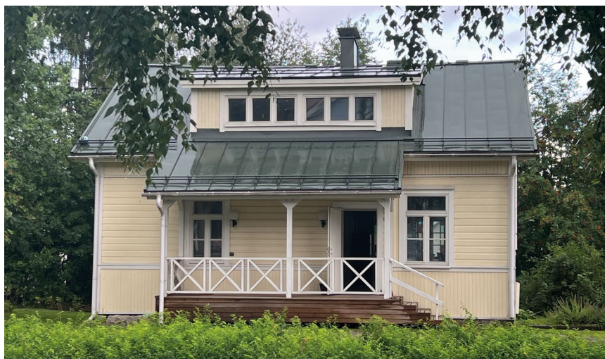
Lottamuseon vieressä sijaitseva ”Valkoinen talo” on otettu käyttöön 1900-luvun alussa. Rakennus on toiminut vuosien aikana mm. puutarhurin talona.
